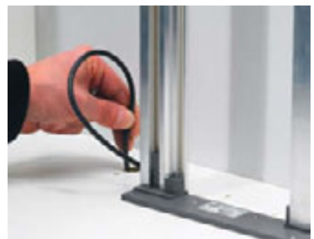
3) Die Anschlussleitung wird durch eine Bohrung im Korpusboden nach unten durchgeführt.
