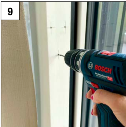
9 Die sieben Befestigungspunkte am Schiebetürflügel mit einem \varnothing 3.0 mm Bohrer 20.0 mm tief vorbohren.
