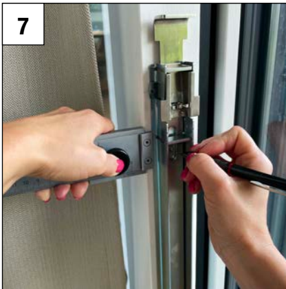
7 Verriegelungs-Mechanik richten und Montagelöcher auf Schiebetür übertragen.
