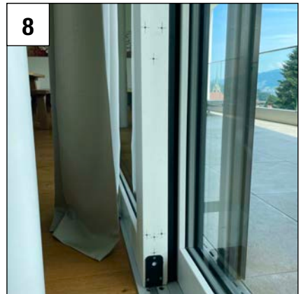
8 Verriegelungs-Mechanik entfernen. Masse und Flucht der übertragenen Punkte prüfen.
