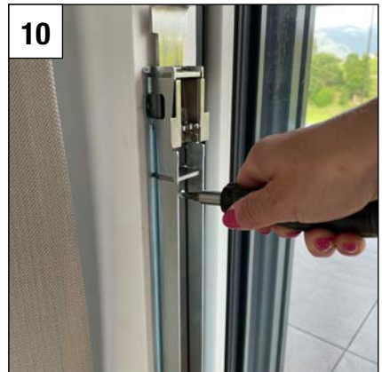
10 Verriegelungs-Mechanik mit den mitgelieferten Schrauben befestigen. Bewegliche Teile leicht schmieren.
