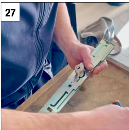
27 Zuhaltung Zylinder entfernen, Zahnradzylinder nullen und in die Verriegelungsmechanik einsetzen. Zuhaltung Zylinder wieder anbringen.
