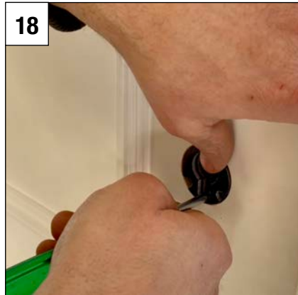
18 Zylinderpanzer Unterlagen 5 mm ebenfalls einsetzen und mit einem Schraubendreher richten. Notwendig bei Zylinderlängen über 52.5 mm (1 Stk für 5 mm).
