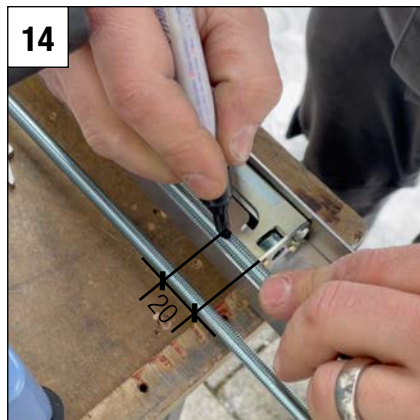
14 Getriebeeinheit und Bolzen gestänge einsetzen. Die Enden der Bolzen richten und ca. 20 mm über der Bolzenaufnahme anzeichnen und abtrennen.
