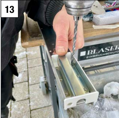
13 Bolzenführung Teil 1 und Teil 2 zusammensetzen. Montagelöcher im Montageprofil übertragen. Mit einem \varnothing 6.0 mm Bohrer 4 x oder 6 x ausbohren.
