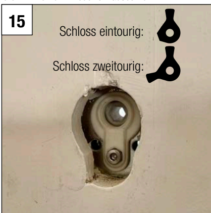
15 Mitnehmer-Kit im Schloss einsetzen. Wichtig, die Sechskantaufnahme muss zum Panzerriegel zeigen und die Mitnehmerführungen müssen am Schloss aufliegen.
