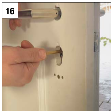
16 Mit dem Sechskantachse den Mitnehmer bedienen! Der Riegel muss ohne grossen Kraftaufwand auslösen.
